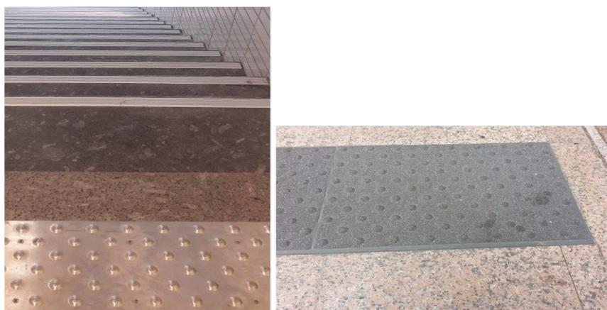
BEV et nez de marche équipé de profilé sur escalier fixe en intérieur de station et BEV sur escalier fixe extérieur
