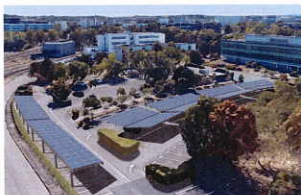
Projet Photovoltaïque Mesplé
