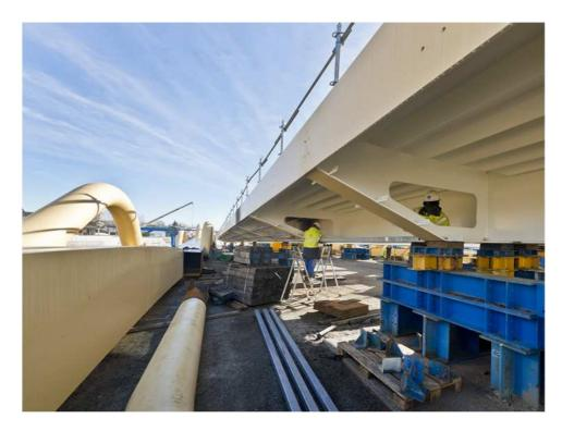
Le viaduc conçu par l'agence d'architecture Richez et Associés, est un ouvrage métallique d'un seul tenant (sans appui central). Il ne comporte en béton que les appuis et les dalles qui seront posées au droit de la plateforme des voies du tramwav.
