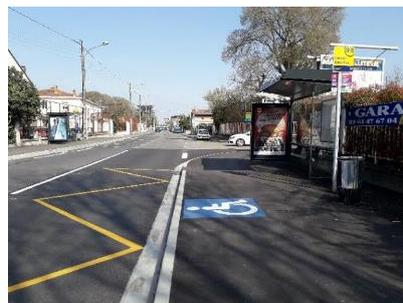
Tous les points d'arrêts seront mis en accessibilité afin d'offrir un service 100% accessible. Certains travaux d'arrêts étant englobés dans une opération de renouvellement urbain pilotée par Toulouse Métropole, cette mise en accessibilité peut être réalisée après la mise en service de Linéo 14, c'est le cas des arrêts Bellefontaine (2025) et Douanes (2024-2025).
