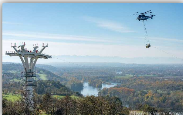
Novembre 2020 - Déroulage des câblettes par drone et hélicoptère
