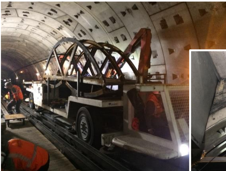
Pose des cintres
