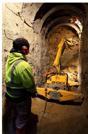
Percement de la voûte
