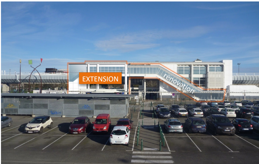
Station Basso Cambo après les travaux d'extension
