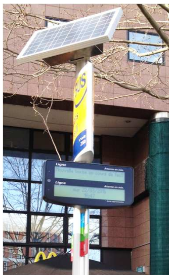
Solaire / EDF / Eclairage
