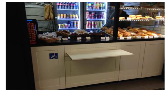
Banque accueil PMR commerce J. d'Arc
