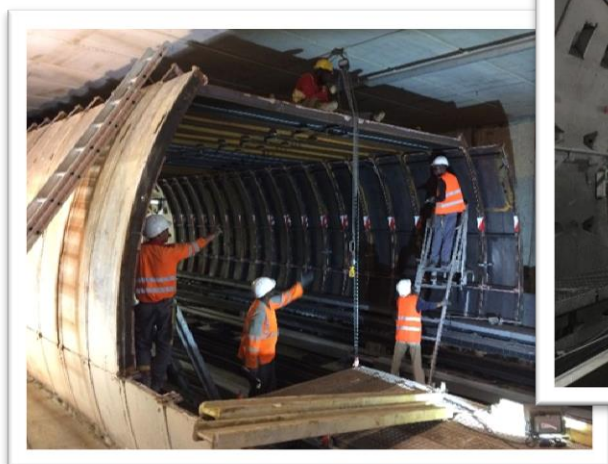
Dépose des cintres Fontaine-Lestang
